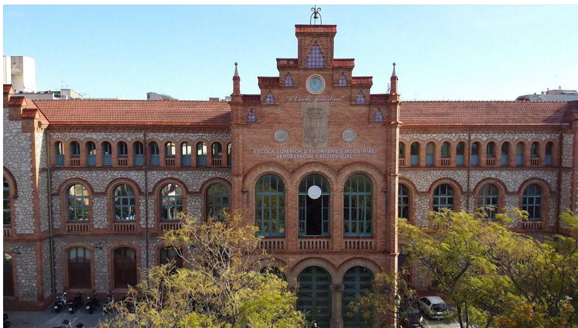
Fotografia 1. Façana de l'edifici TR-1.
